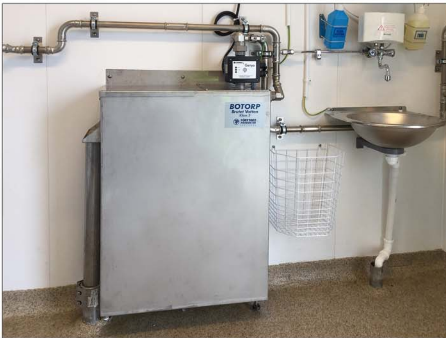
Botorp monterat i pumpstations överbyggnad
